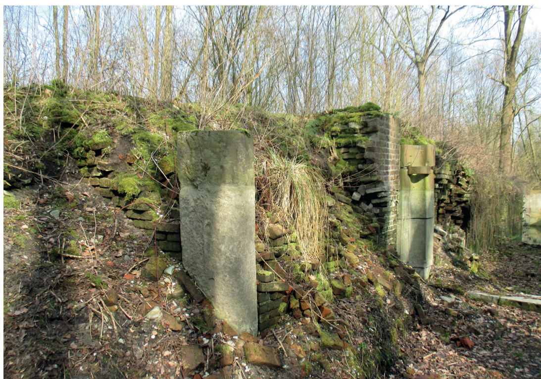
Figuur 1 - Linker sluiswand stroomafwaarts. Foto Frances Kannekens (2016)
