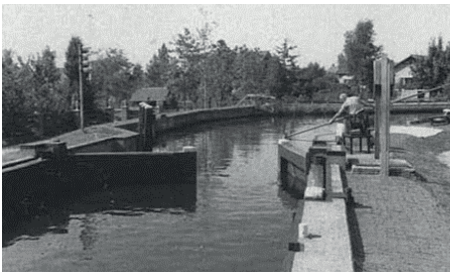
Figuur 12 Voorbeeld van een hand- matig bedienbare puntdeur met boothaak, Arends, G.J., (1994) Sluizen en stuwen
