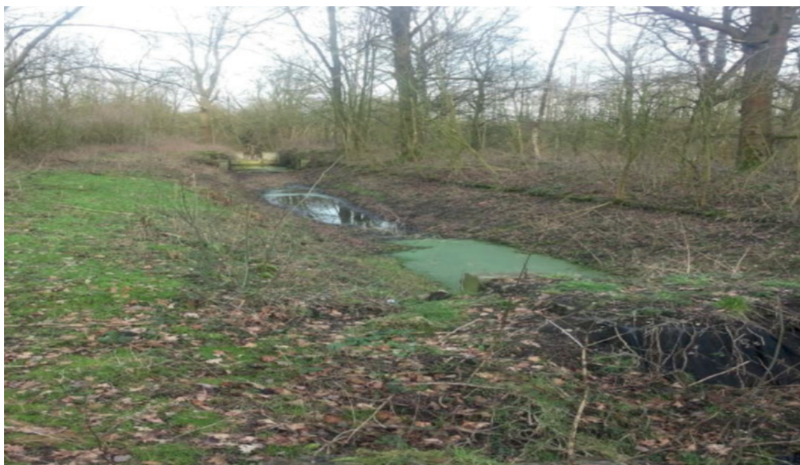
Figuur 21 Slechte staat van toe- voerkanaal en sluis. Foto Frances Kanne- kens (2016)
