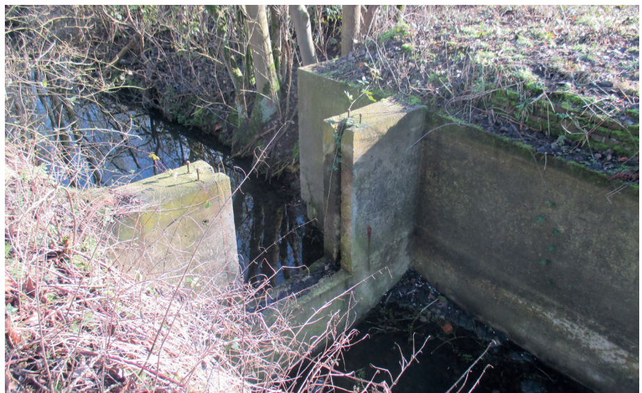
Figuur 18 Betonnen stuw in sluishoofd. Foto Frances Kannekens (2016)
